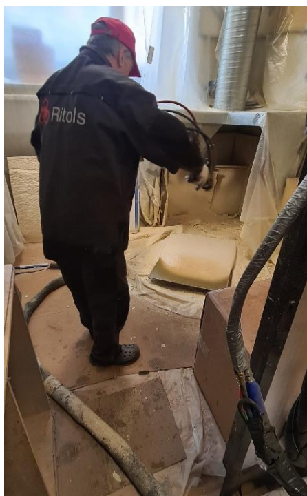
1.attēls. Poliolu sistēma tiek izsmidzināta un alumīnija plāksnes.
