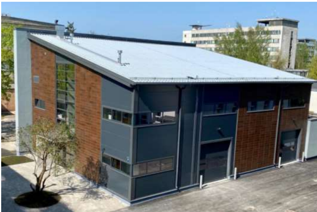
1.16. att. Pilotiekārtu angārs
