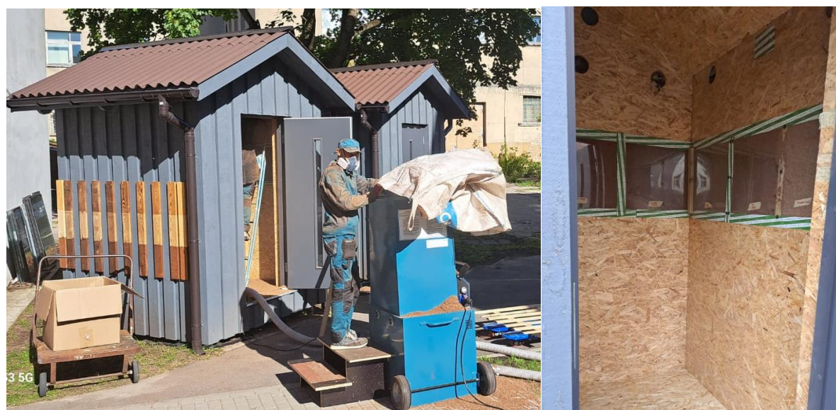
Attēls: projekta ietvaros izstrādātu beramās siltumizolācijas prototipu iepūšana sienu konstrukcijās.
